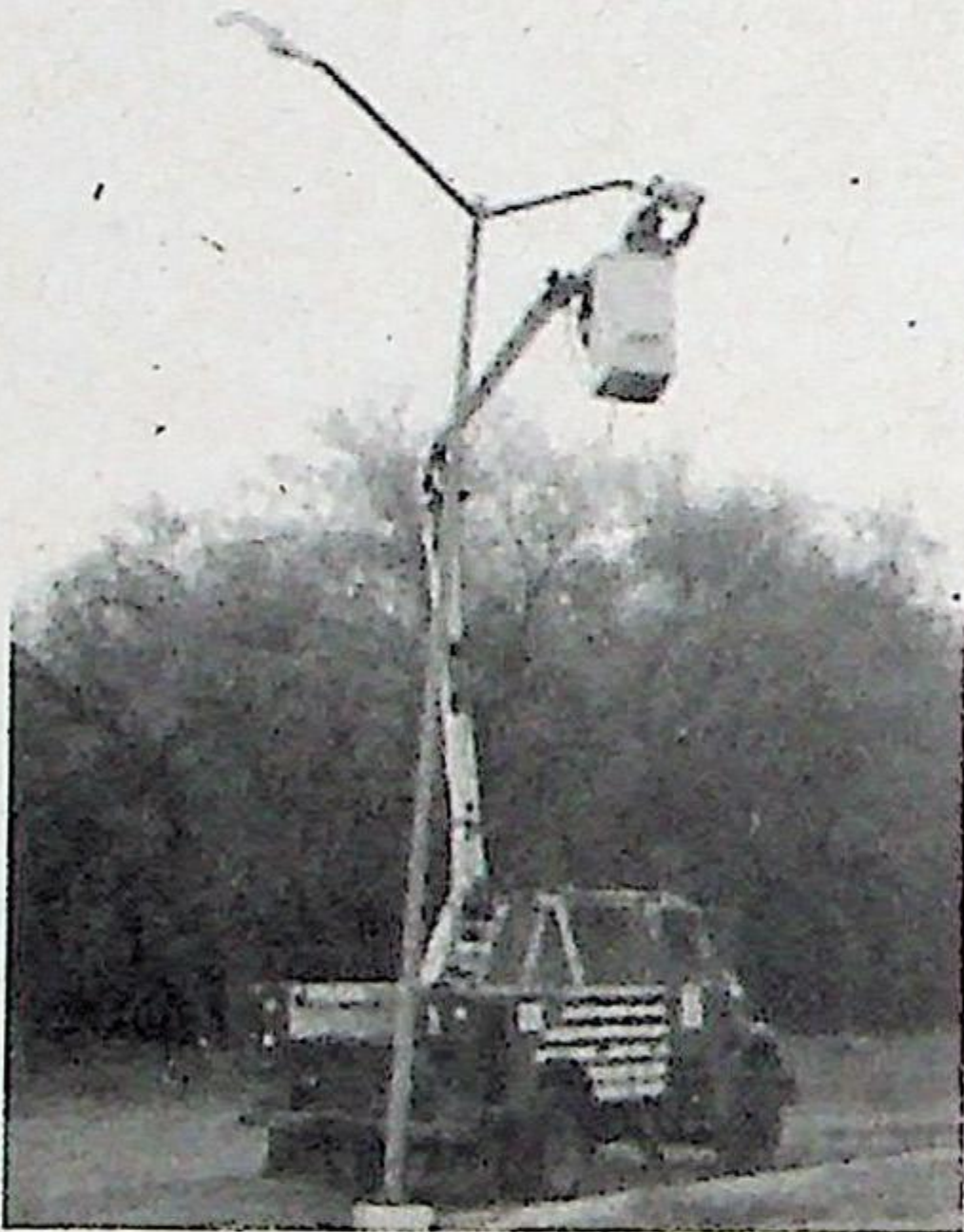
Cuadrillas realizan acciones de reconexión y reparación, entre otras
