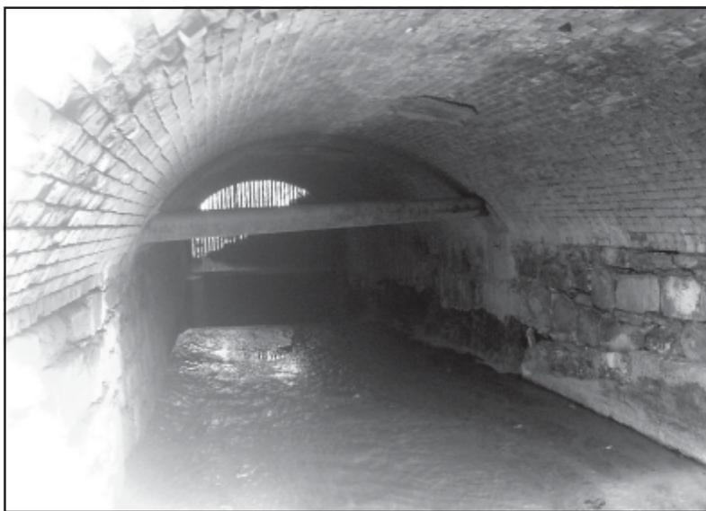
Bóveda de cañón, del Puente de Tacubaya fabricada en ladrillo .
